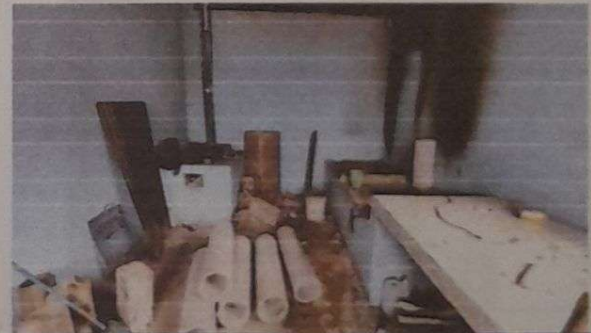
Foto 4: Material para la instalación de planchas para leña y con ducto de concreto.
