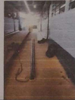
Foto 2: preparativos de corte y medidas de costaneras para posteriormente hubicarlo dentro de la estructura.
