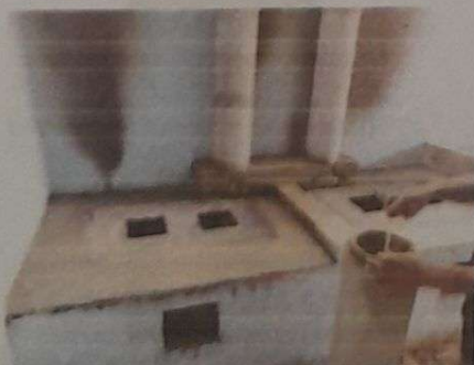
Foto 5: Colocación de planchas de metal para la respectiva chimenea.
