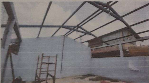
Foto 3: Colocación de costaneras como estructura principal de mantenimiento.
