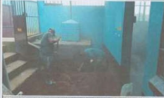
Foto 13: Suministro de materiales y fabricación de cuneta para caída de agua pluvial frente a gradas módulo 2
