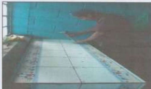
Foto 12: Suministro de materiales para la colocación de azulejo en mesa de concreto en la cocina.
