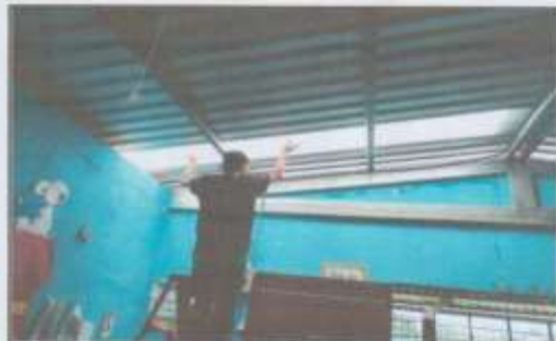
Foto 10: Sustitución de lámina troquelada, por lámina traslucida en aulas de módulo 1.
