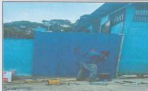
Foto 8: Sustitución de portón de metal, por portón corredizo de metal con una puerta abatible de la entrada principal de la escuela.
