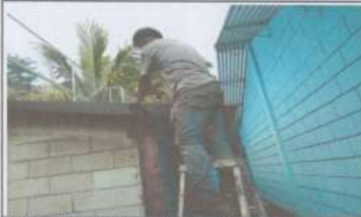
Foto 1: Sustitución de lámina, por lámina acanalada en sanitarios
