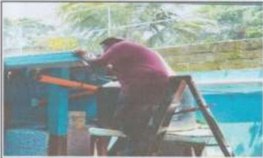
Foto 3: Suministro e instalación de canal de PVC con bajada de agua pluvial en sanitarios
