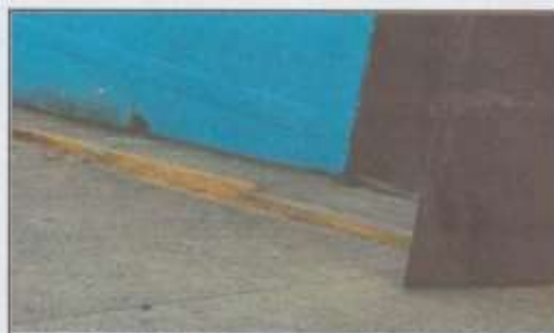
Foto 18: Fundición de base de concreto para riel de portón de 0.10 x 0.40
