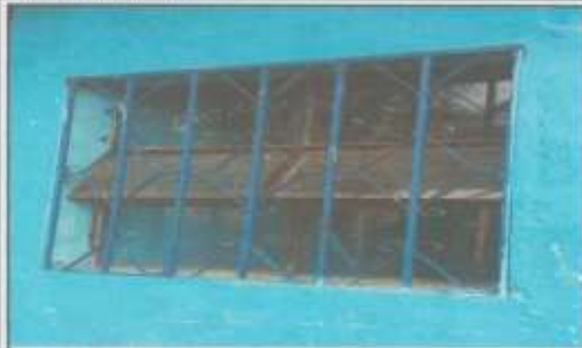
Foto 7: Sustitución de ventana de vidrio y metal por ventana de PVC corrediza en aula de módulo 1
