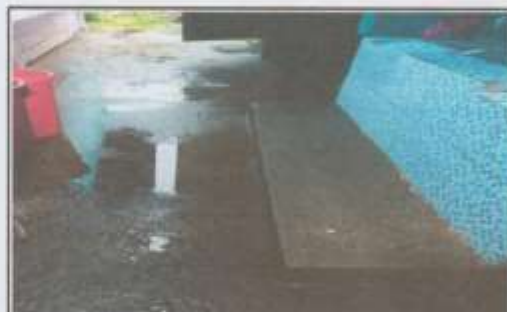
Foto 4: Suministro e instalación de rejilla pluvial en sanitarios y frente a gradas de módulo 2
