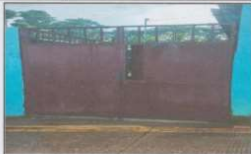
Foto 8: Sustitución de portón de metal, por portón corredizo de metal con una puerta abatible de la entrada principal de la escuela
