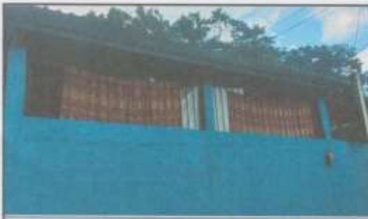
Foto 5: Suministro e instalación de ventanas corredizas con perfilaría en aula de módulo 1
