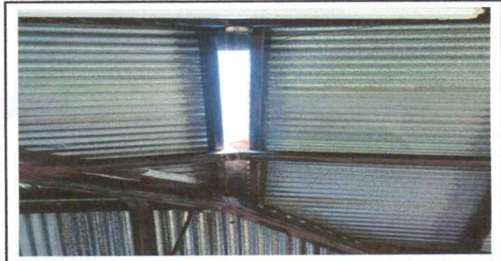
Pintura de costanera
