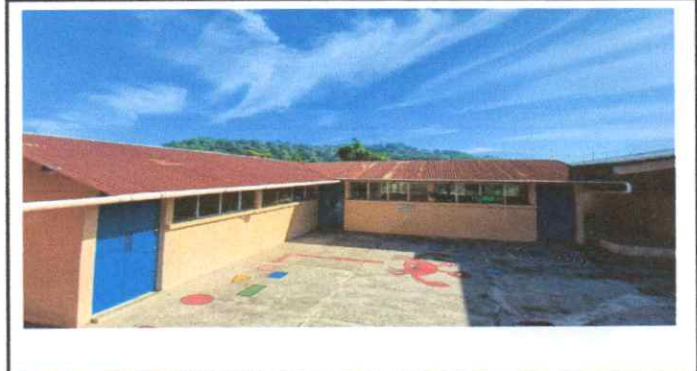
MANO DE OBRA sustitucion de laminas en 3 aulas y estructura metalica de techo de patio
