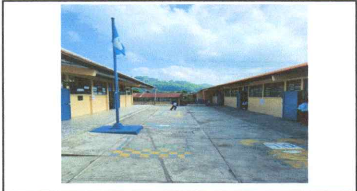
MANO DE OBRA sustitucion de laminas en 3 aulas y estructura metalica de techo de patio
