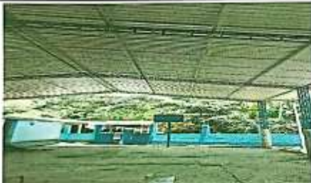
Foto 3: VISTA DE ENTECHADO FINALIZADO
