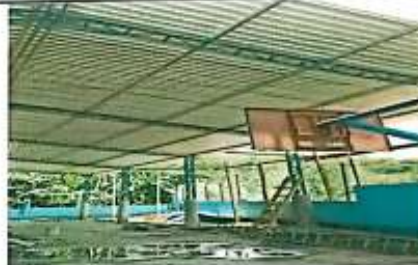
Foto 2: VISTA DE INSTALACIÓN DE LÁMINA FINALIZADO
