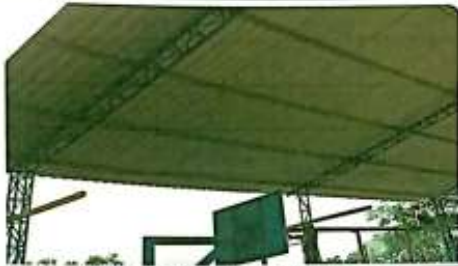
Foto 1: VISTA FACHADA INTERIOR LAMINA COLOCADA AL 100%
