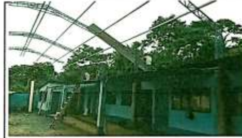
Foto 4: Colocación de estructura para entechado.
