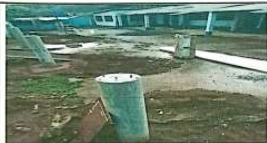
Foto 3: Columnas para colocar estructura metálica
