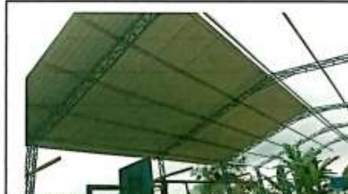
Foto 6: Avance en la colocación de láminas
