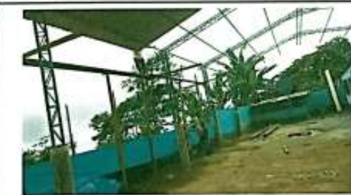
Foto 5: SUMINISTRO E INSTALACIÓN DE LÁMINAS
