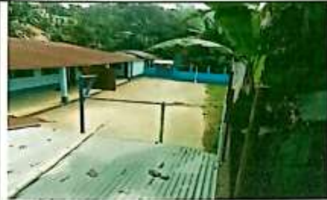
Foto 1: Cancha sin techo
