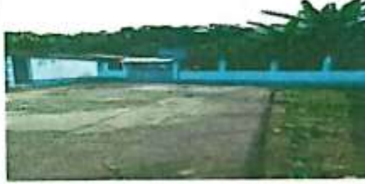
suministro e instalación de cimentación de la cancha
