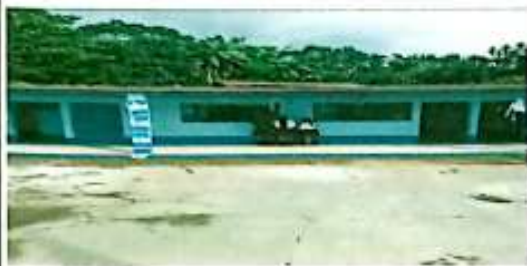
suministro e instalacion de columnas para entechado de la cancha
