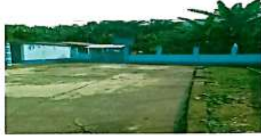
suministro e instalacion de cimentación de la cancha
