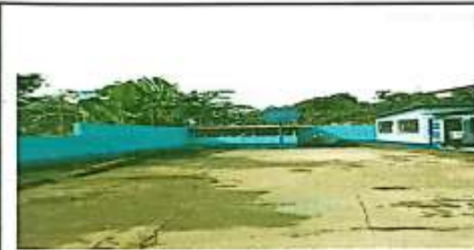
suministro e instalacion de cubierta de lamina troquelada
