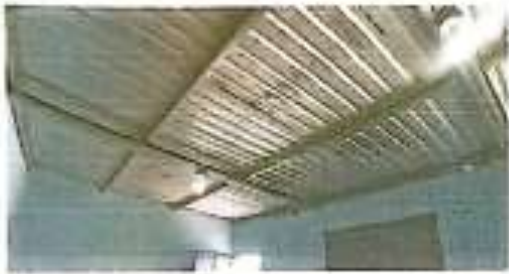
Foto 3: ESTRUCTURA METÁLICA, SISTEMA ELÉCTRICO, LÁMINAS DE TECHO
