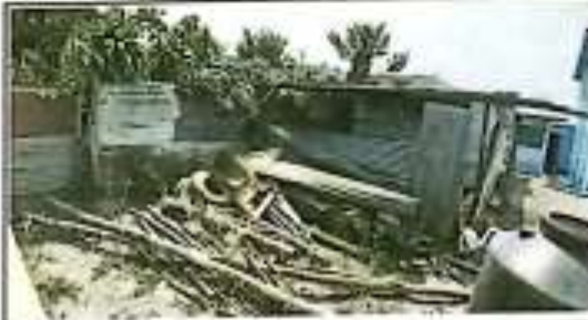
Foto 2: sustitución muro perimetral
