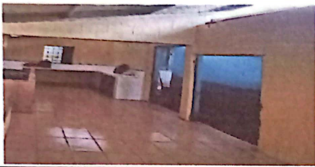
Foto 1: VISTA INTERIOR DE PISO DE COCINA
