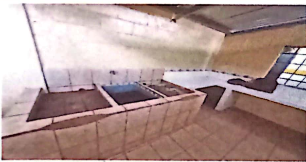
Foto 3: VISTA DE PILA CON AZULEJO INTERIOR
