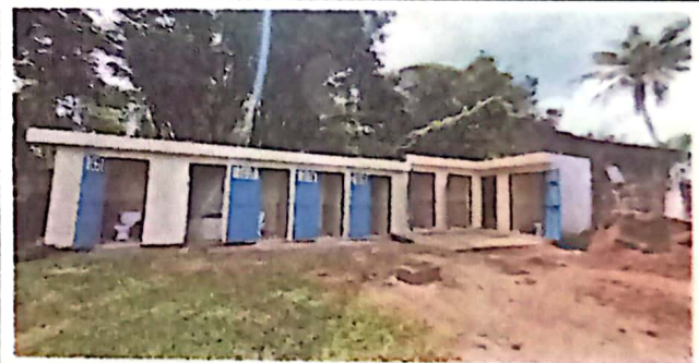
Foto 4: VISTA EXTERIOR DE SANITARIOS
