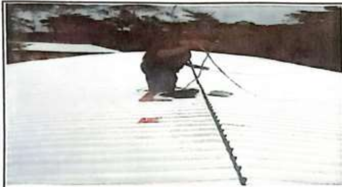
Foto 3: SUMINISTRO E INSTALACIÓN DE CAPOTES EN TECHO
