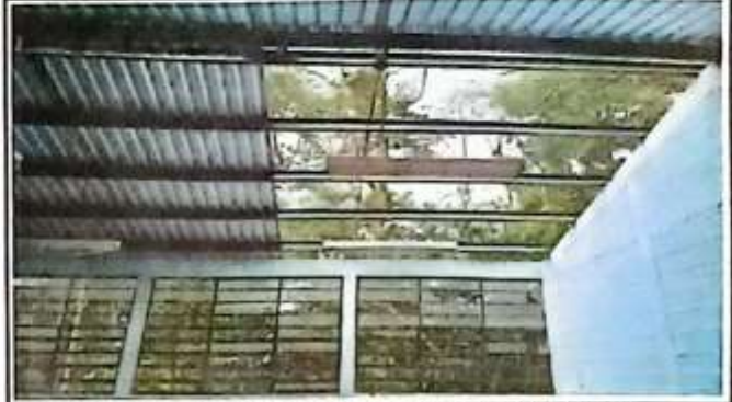
Foto 2: SUMINISTRO E INSTALACIÓN DE LÁMINA PRIMERA FASE
