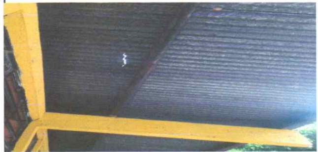
Pintura anticorrosivo corona
