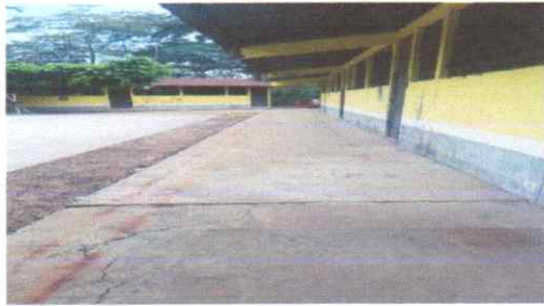
Suministro de materiales de techo, Lámina metalica , troquelada aluzinc, 880 M2 2,888 pies
