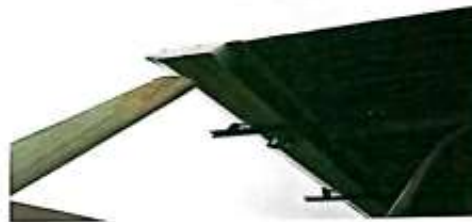
Suministro y sustitución de canales tipo Americano
