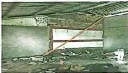
Suministro y reparación de muro de block de dirección, en módulo 2
