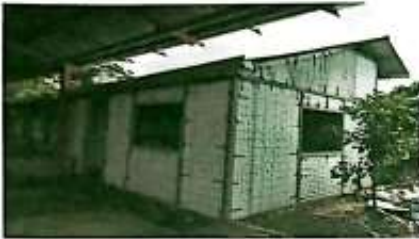
Suministro e instalación de aula prefabricada de 30 m2
