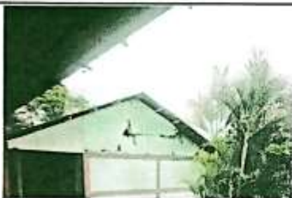
Suministro y reparación de muro de block de dirección, en módulo 2
