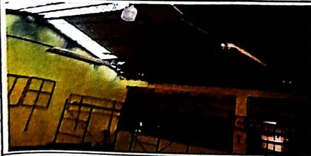
Foto 5: SUMINISTRO E INSTALACIÓN DE LÁMINAS ALUZINC CALIBRE 26
