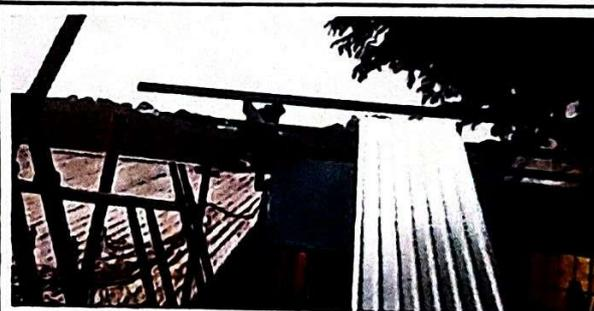
Foto 4: SUSTITUCIÓN DE LÁMINA DE ZINC POR ALUZINC CALIBRE 26
