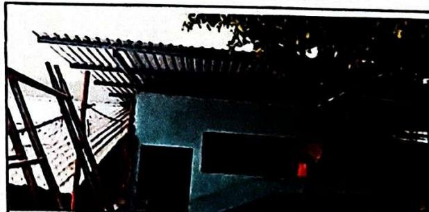
Foto 6: SUMINISTRO E INSTALACIÓN DE LÁMINAS ALUZINC CALIBRE 26
