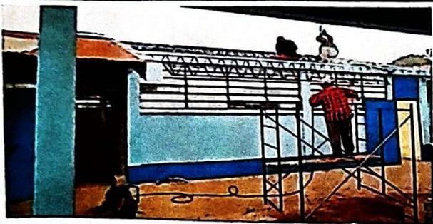
Foto 1: RETIRO DE LÁMINA DE ZINC, PARTE DEL PRIMER MÓDULO
