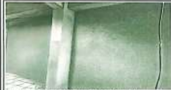
Foto 3: SUSTITUCIÓN DE REPELLO Y CERNIDO EN PAREDES
