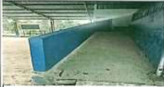
Foto 1: SUSTITUCIÓN DE BARRANDA DE MALLA POR PARED PREFABRICADA
