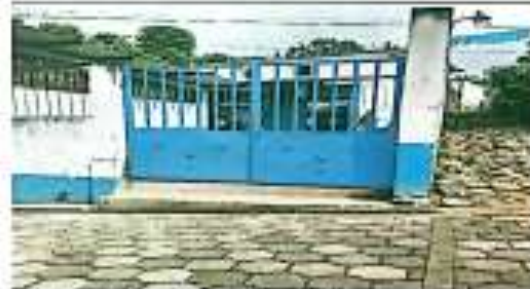
Foto 4: SUSTITUCIÓN DE PORTÓN PRINCIPAL
