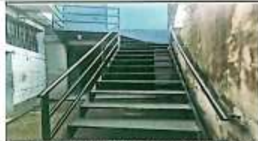
Foto 2: INSTALACIÓN DE GRADAS HACIA SEGUNDO NIVEL EN EL AREA FOTOGRAFIADO.
