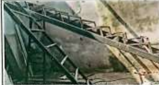
Foto 2: INSTALACION DE GRADAS HACIA SEGUNDO NIVEL EN EL AREA FOTOGRAFIADO
