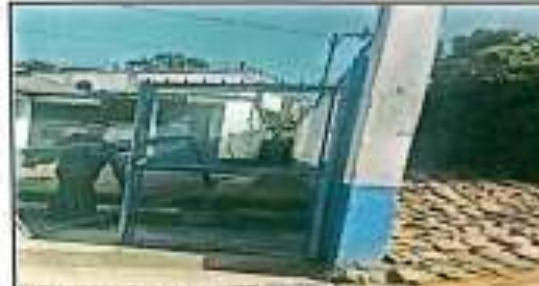
Foto 4: SUSTITUCION DE PORTON PRINCIPAL
