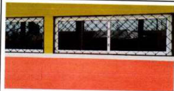
Suministros, fabricación e instalación de ventanas corredizas de pvc blanco con vidrio claro de 5mm 2.80 x 1.04
