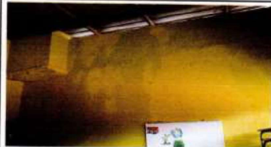
Suministros, trabajo en 158mts2: limpieza y aplicación de pintura en paredes de interior en área de aula.
