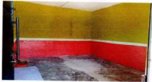
Suministro, trabajo en 156 mts2: limpieza y aplicación de pintura de agua para interior de 1 aula y exterior unicamente parte de enfrente de 1 aula
