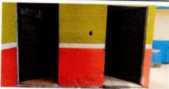
Reparación de puertas de baño, (cambio de lado, cambio de chapa y aplicación de pintura). 0.90 x 2.10
