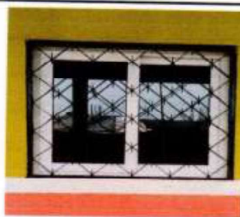
Suministros, fabricación e instalación de ventanas corredizas de pvc blanco con vidrio claro de 5mm 1.08 x 1.04
