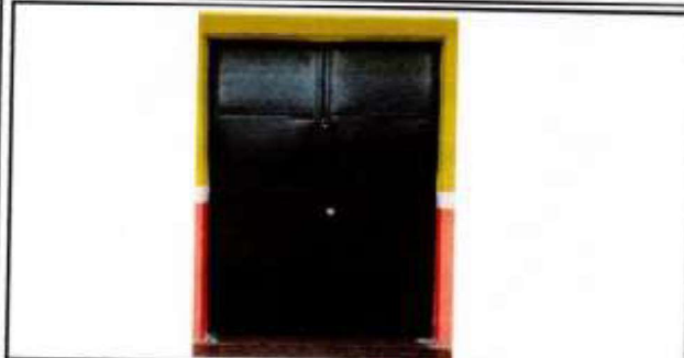
Suministros, fabricación e instalación de puertas de metal de dos hojas 1.45 x 2.10
