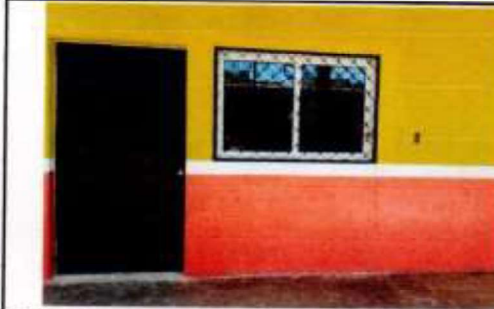
Abertura de vano de puerta. 1.00 X 2.10
