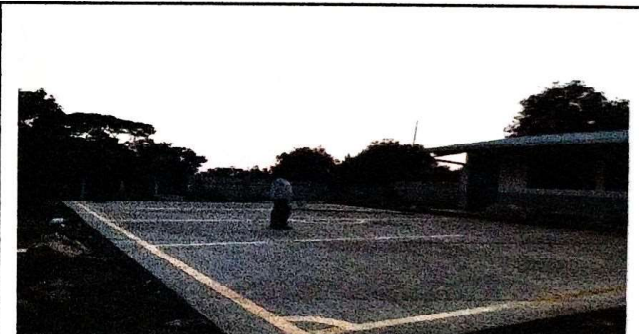
Foto 4: APLICACIÓN DE PINTURA EN CANCHA.
