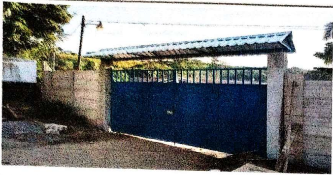
Foto 1: SUMINISTRO E INSTALACION DE PORTON
