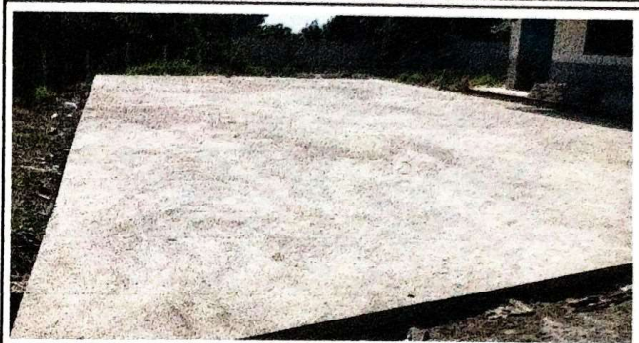
Foto 2: SUMINISTRO Y SUSTITUCION DE TORTA DE CONCRETO EN CANCHA
