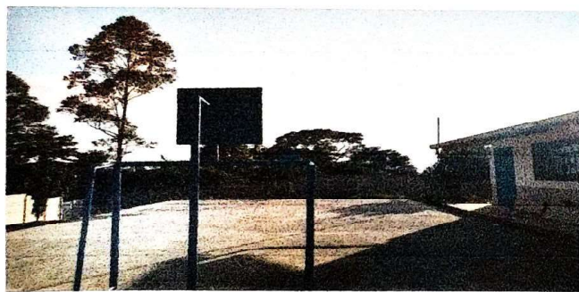
Foto 3: SUMINISTRO E INSTALACION DE PORTERIAS
