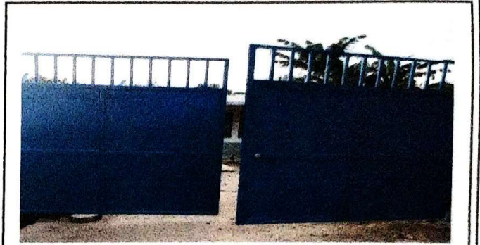
Foto 2: SUMINISTRO E INSTALACION DE PORTON.
