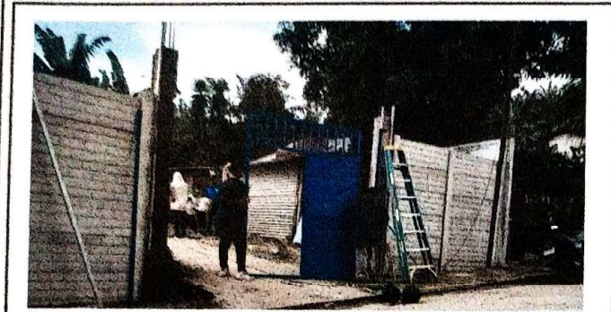
Foto 1: SUMINISTRO E INSTALACION DE PORTON.
