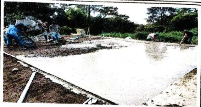
Foto 2: SUMINISTRO Y SUSTITUCION DE TORTA DE CONCRETO EN CANCHA
