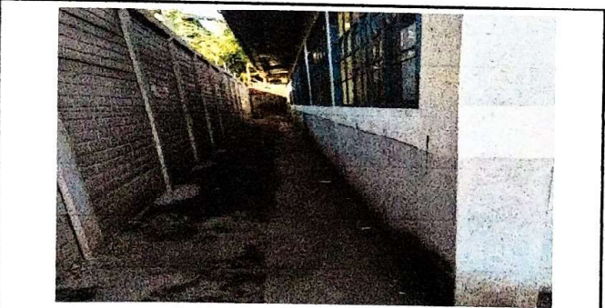
Foto 3: SUMINISTRO E INSTALACION DE MURO PERIMETRAL PREFABRICADO DE 3 METROS DE ALTURA
