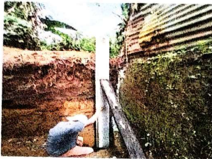
Foto1: SUMINISTRO E INSTALACION DE MURO PERIMETRAL PREFABRICADO DE 3.00 METROS DE ALTURA
