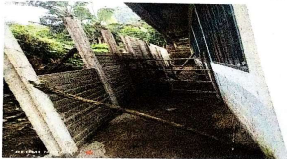
Foto 3: SUMINISTRO E INSTALACION DE MURO PERIMETRAL PREFABRICADO DE 3 METROS DE ALTURA
