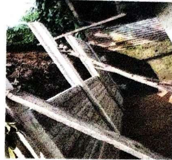
Foto 2: SUMINISTRO E INSTALACIÓN DE MURO PERIMETRAL PREFABRICADO DE 3.00 METROS DE ALTURA.
