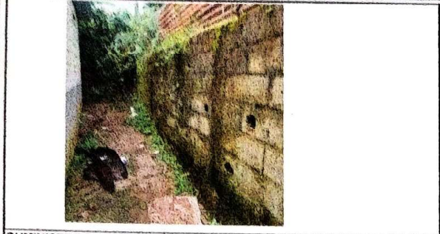
SUMINISTRO E INSTALACIÓN DE MURO PERIMETRAL PREFABRICADO DE 3.00 METROS DE ALTURA
