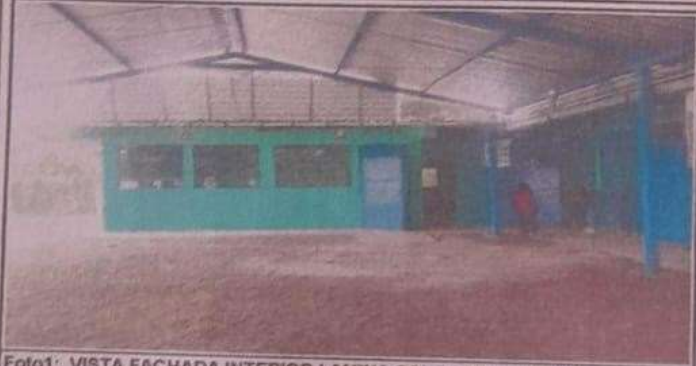
Foto 1: VISTA FACHADA INTERIOR LAMINA COLOCADA AL 100%
