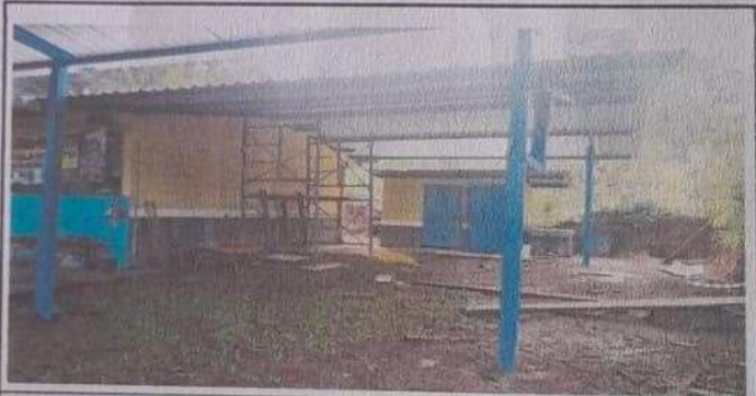
Foto 4: SUMINISTRO E INSTALACION DE LAMINAS
