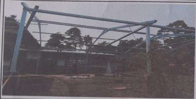
Foto 1: Instalacion de estructuras metalicas para el entechado
