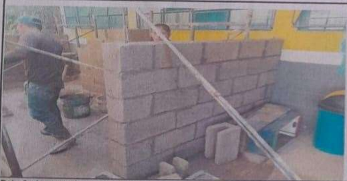
Foto 3: levantado de dos muros
