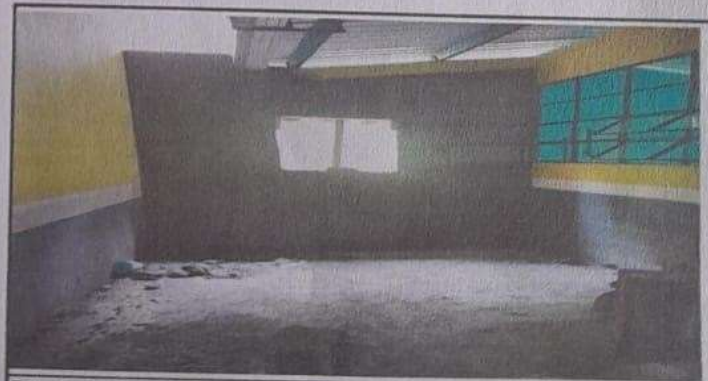
Foto 6: FINALIZA LA COLOCACION DE MUROS
