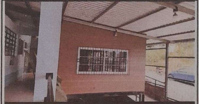
Foto 2: VISTA FRONTAL DE SUMINISTRO E INSTALACIÓN DE BASE DE ESTRUCTURA METÁLICA Y PANELES U.P.V.C. COLOCADA AL 100%
