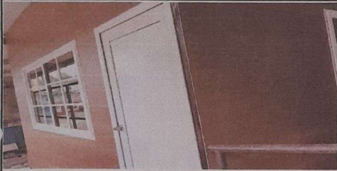
Foto 1: VISTA LATERAL DERECHA, FACHADA DE SUMINISTRO E INSTALACIÓN DE BASE DE ESTRUCTURA METÁLICA Y PANELES U.P.V.C. COLOCADA AL 100%
