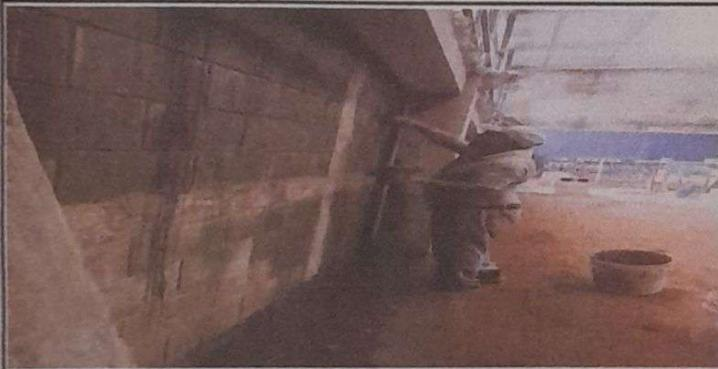
Foto 3: REPARACIÓN DE MUROS CON REPELLO E IMPERMEABILIZACIÓN
