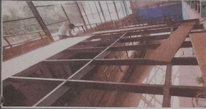
Foto 1: SUMINISTRO E INSTALACIÓN DE BASE DE ESTRUCTURA METÁLICA Y PANELES U.P.V.C.
