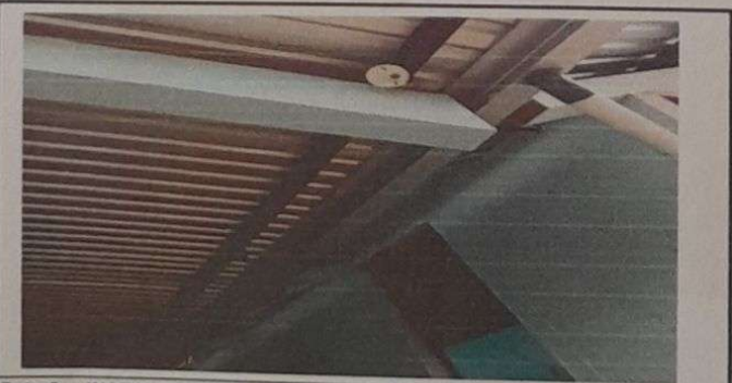
Foto 5: INSTALACION DE CANAL PARA BAJADA PLUVIAL TERMINADA
