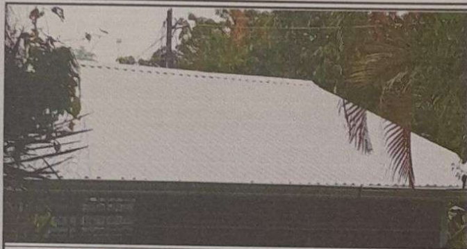
Foto 1: VISTA PARTE DE ATRÁS, LÁMINA COLOCADA AL 100%
