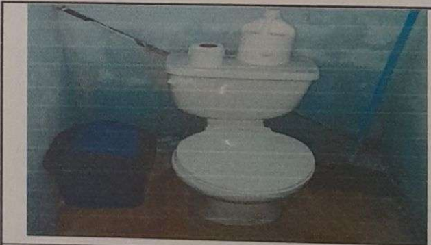
Foto 4: INSTALACION COMPLETA DE LOZA SANITARIA
