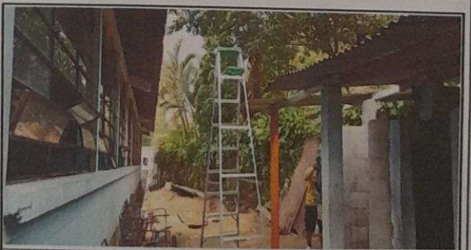
Foto 6: MANTENIMIENTO INSTALACIÓN DE TECHO EN EL AREA DE SANITARIOS.
