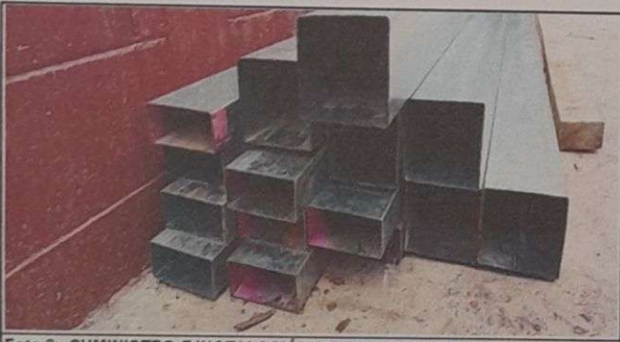
Foto 3: SUMINISTRO E INSTALACIÓN DE ESTRUCTURA METALICA
