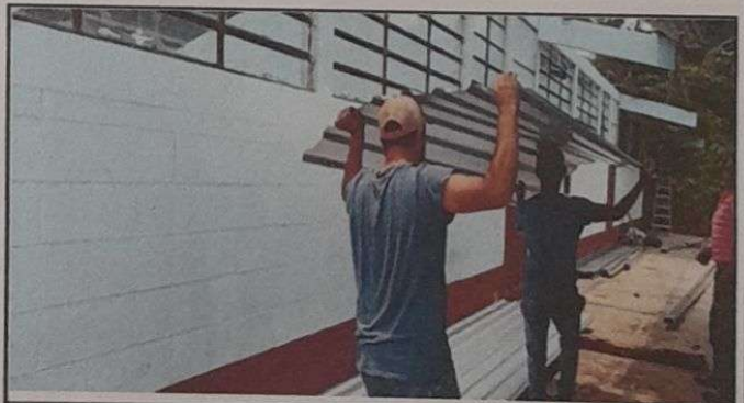
Foto 4: MANTENIMIENTO INSTALACIÓN DE TECHO NUEVO
