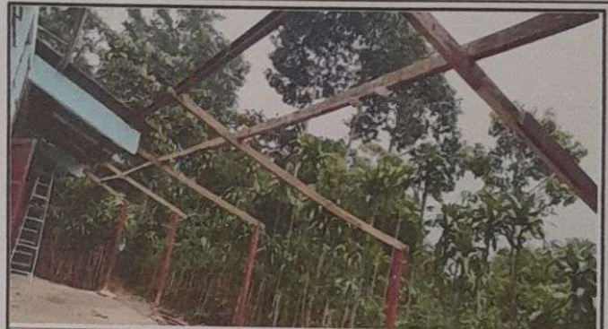
Foto 2: Retiro de Lamina y madera en el Corredor del Establecimiento.
