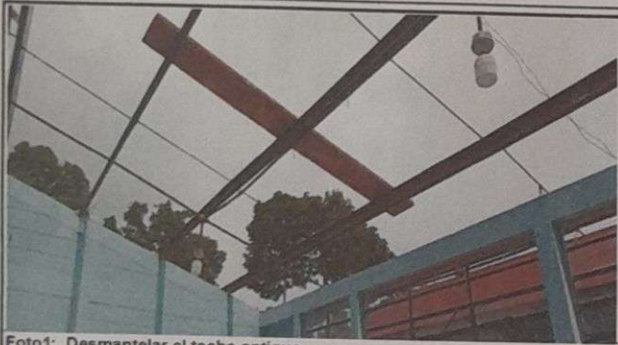
Foto 1: Desmantelar el techo antiguo
