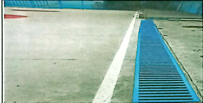
Foto 3: (SE INCLUYÓ UNA REJA DE METAL ENTRE EL MÓDULO 1 y 2 DEBIDO AL REPOSO DEL AGUA DE LLUVIA SOBRE LA CANCHA, ESPECIALMENTE POR LAS TARDES)
