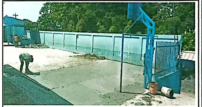
Foto 4: SUMINISTRO CAMBIO DE PLANCHAS DE PISO DE CONCRETO
