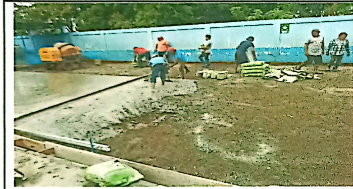
Foto 3: SUMINISTRO DE PLANCHAS DE CONCRETO DE PATIO (178.50 m2)
