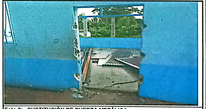
Foto 6: SUSTITUCIÓN DE PUERTA METÁLICA
