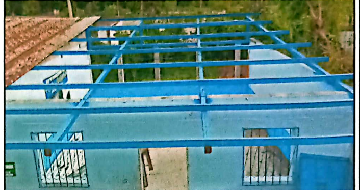
Foto 2: SUMINISTRO CAMBIO DE LÁMINAS
