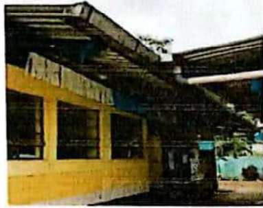
Mantenimiento con pintura anticorrosiva a estructura de ventanas
