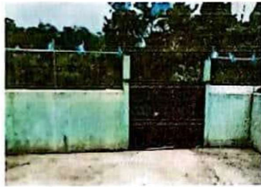
Suministro e instalación de malla en area de patio
