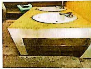
Suministro y reparación de grifos en lavamos
