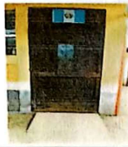
Reparacion de puerta de metal
