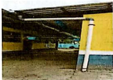
Suministro y sustitucion de canal y bajadas de agua
