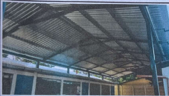
Foto 3: Suministro y sustitución de lámina acanalada por lámina troquelada calibre 26"
