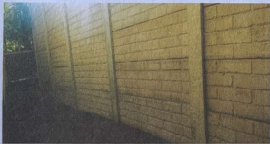
Foto 5: Suministro e instalación de muro perimetral prefabricado
