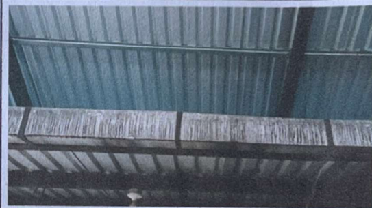
Foto 4: Suministro y sustitución de lámina acanalada por lámina troquelada calibre 26"
