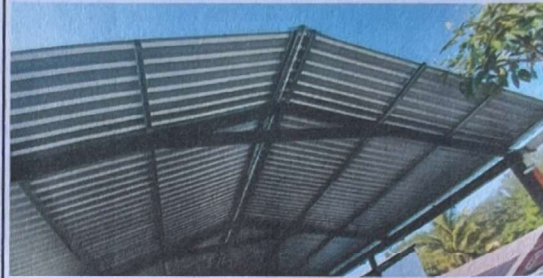
Foto 2: Suministro y sustitución de madera por estructura metálica para techado
