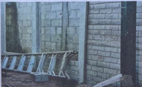
Foto 5: Suministro e instalación de muro perimetral prefabricado
