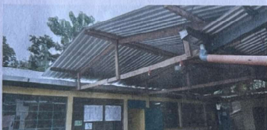
Foto 3: Suministro y sustitución de lámina acanalada por lámina troquelada calibre 26"
