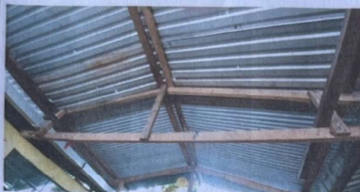
Foto 1: Suministro y sustitución de cimentación para estructura de techado
