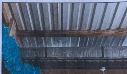
Foto 4: Suministro y sustitución de lámina acanalada por lámina troquelada calibre 26"
