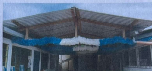
Foto 2: Suministro y sustitución de madera por estructura metálica para techado
