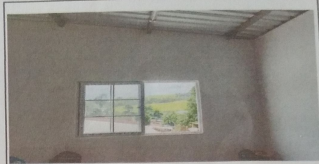
FOTO 2: VISTA DE INSTALACIÓN DE PAREDES
