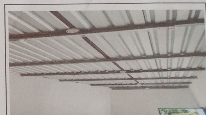
FOTO 4: VISTA DE SUMINISTRO DE INSTALACIÓN DE LAMINAS
