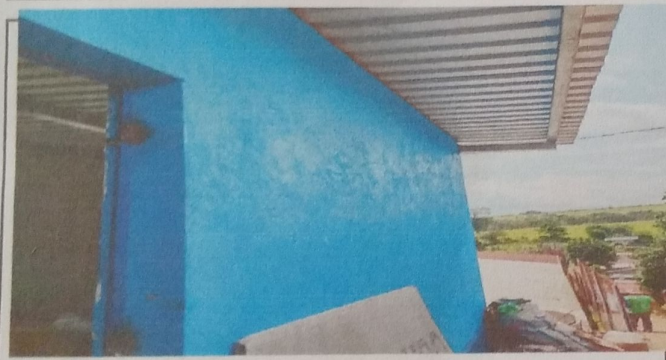
FOTO 3: VISTA EXTERIOR DE PAREED
