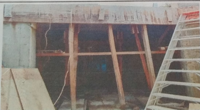
FOTO 5. INSTALACIÓN DE VIGAS
