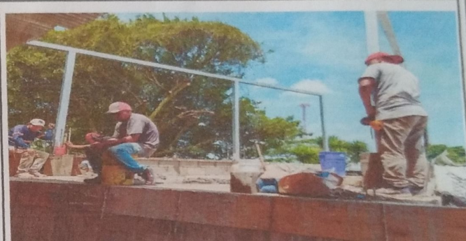
FOTO 4: VISTA DE VIGAS
