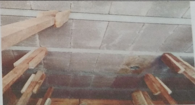
FOTO 6: INSTALACIÓN DE TERRAZA
