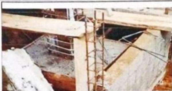
Foto 1: colado de zapatas
