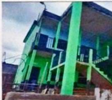
Foto 4: Finalización de columnas
