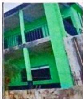
Foto 3: Finalización de columnas
