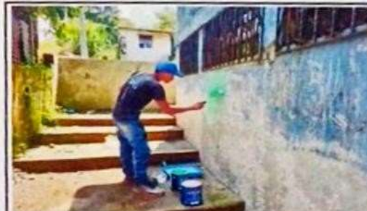
Foto 6: inicio de impermeabilización de pared No.2
