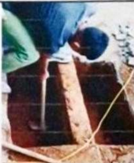
Foto 1: excavación previo al mantenimiento de zapatas de concretos.
