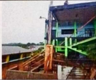
Foto 4: encofrado de columnas
