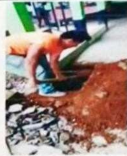
Foto 2: excavación previo al mantenimiento de zapatas de concretos.
