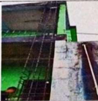
Foto 3: armadura de columnas
