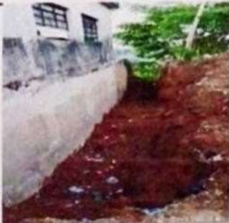
Foto 5: excavación previa la impermeabilización pared No.1
