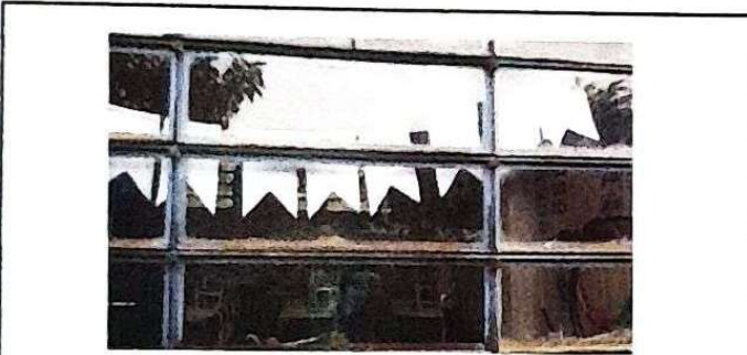
Foto 3: Suministro y Sustitución de vidrios de ventanas de 5mm
