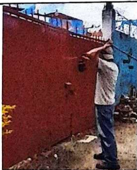
Foto 5: Mantenimiento a porton de metal.
