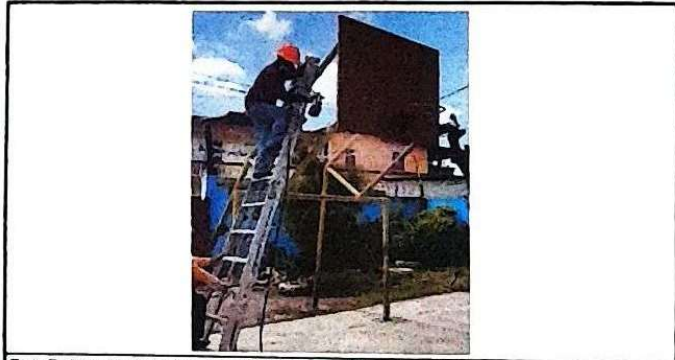
Foto7: Mantenimiento de estructura metálica (cancha).
