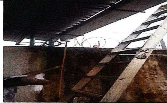
Foto 4: Suministro e Instalación de canal de PVC.
