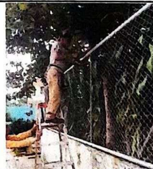
Foto 6: Suministro y Sustitución de malla de muro perimetral.
