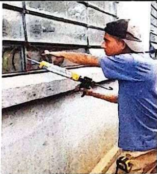
Foto 3: Suministro y Sustitucion de vidrios de ventanas de 5mm.
