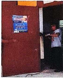
Foto1: Suministro y Sustitución de puertas metálicas.
