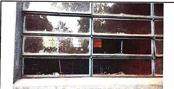
Foto 3: Suministro y sustiticon de vidrios de ventana de 5mm.
