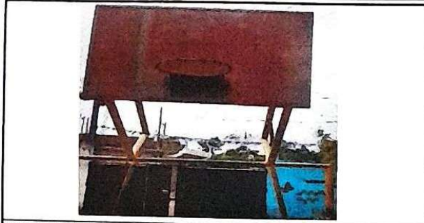
Foto 1: Mantenimiento de estructura metalica (Cancha).
