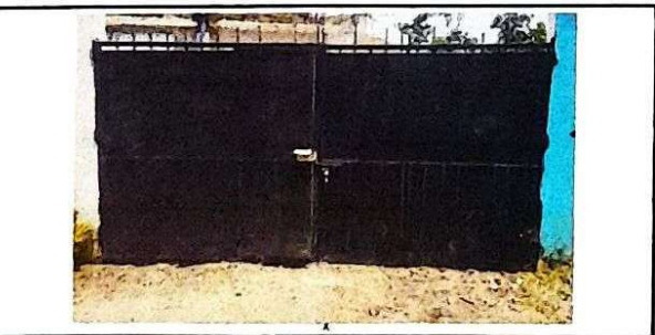
Foto 5: Mantenimiento a porton de metal.
