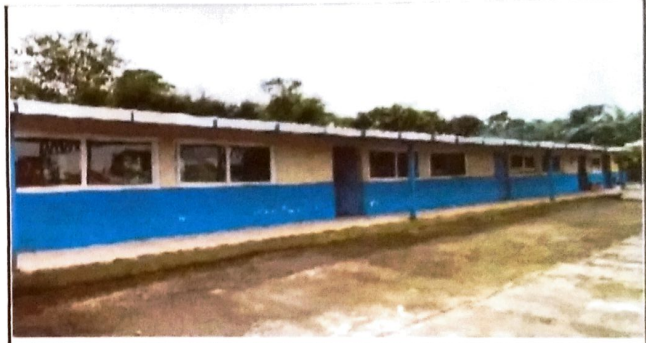
Foto 4: COLOCACIÓN DE CANAL DE METAL
