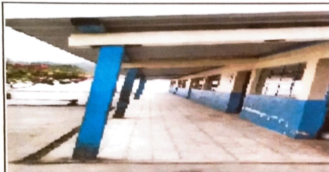
Foto 3: SUMINISTRO E INSTALACIÓN DE CANAL DE METAL
