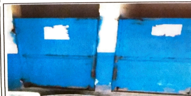
Foto 5: SUMINISTRO E INSTALACIÓN DE PUERTAS
