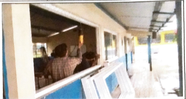
Foto 2: SUMINISTRO E INSTALACIÓN DE VENTANA DE PVC PRIMERA FASE
