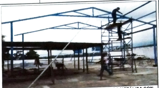
Foto 2: SUMINISTRO E INSTALACIÓN DE ESTRUCTURA METÁLICA CON ANTICORROSIVO PRIMERA FASE
