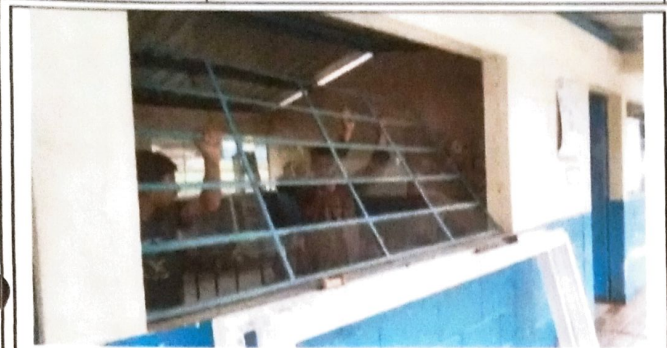
Foto 1: RETIRO DE VENTANAS ANTIGUAS DE METAL
