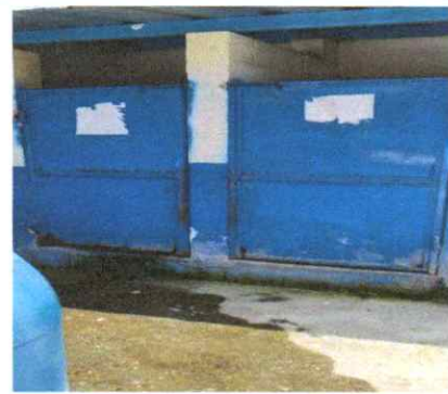
Sustitución de puerta metálica
