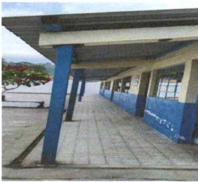
Implementación de canal de PVC
