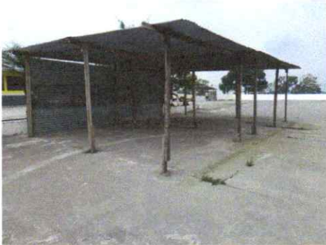
Mantenimiento a estructura de soporte de metal con anticorrosivo
