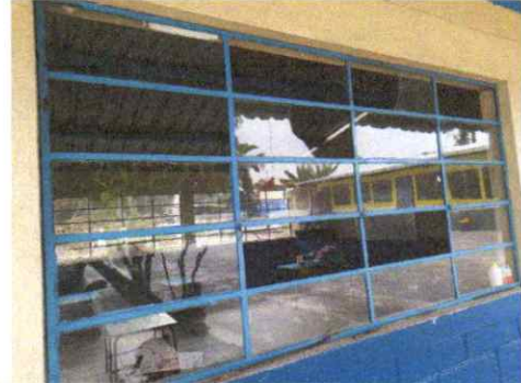
Sustitución de estructura de metal de ventana
