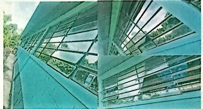
Foto 2: Sustitución de vidrios transparentes 5mm
