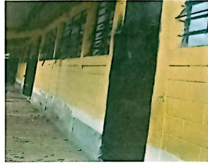
Foto 2: Sustitución de vidrios transparentes 5mm
