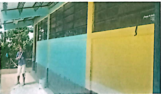
Foto 5: Suministro y aplicación de pintura general en muros interiores y exteriores
