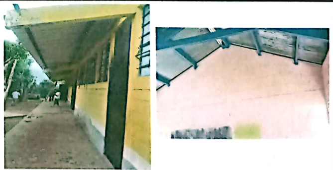
Foto 6: Suministro y aplicación de pintura general en muros interiores y exteriores
