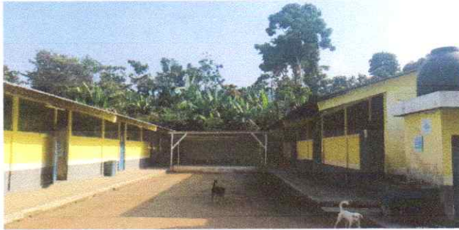
Sumnistro y aplicación de pintura general en muros interiores y exteriores
