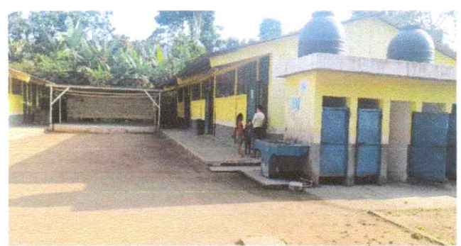
Mantenimiento de salon usos multiples
