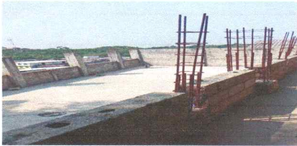
SUMINISTRO E INSTALACIÓN DE CUBIERTA DE LAMINATROQUELADA CALIBRE 26 MÁS ESTRUCTURA METALICA
