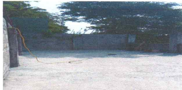
SUMINISTRO E INSTALACIÓN DE PISO CERÁMICO
