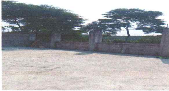
SOLERA FINAL EN AREA DE VENTANAS Y SUMINISTRO E INSTALACIÓN DE VENTANAS PVC
