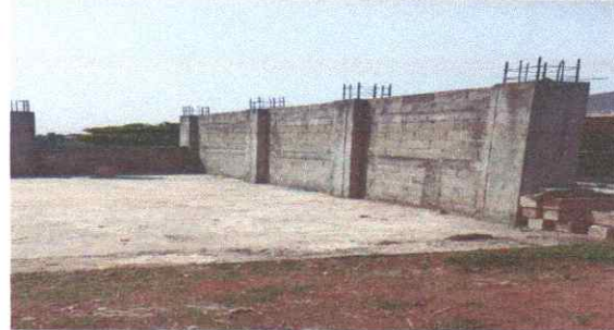
SOLERA MOJINETE (INCLUYE LEVANTADO DE BLOCK)
