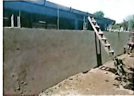
Foto 2: proceso de repello cara exterior
