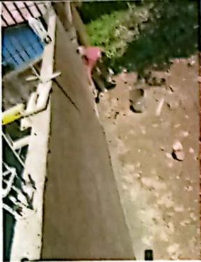
Foto 1: Cara exterior de pared perimetral en proceso de repello
