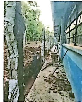
Foto 4: Zanjeo del área donde se colocarán los bloks para la nueva pared
