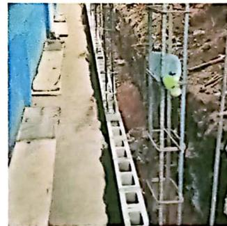
Foto 6: Levantado de nuevo muro perimetral.
