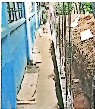
Foto 5: Centrado de columnas para pared perimetral
